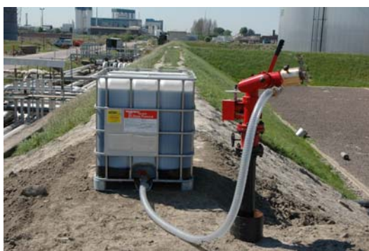
Figuur 10: voorbeeld van een automatisch oscilerende monitor met schuimconcentraat bijmenging
